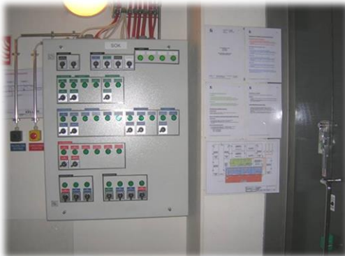
Kuva 53. vasemmalla koneellisen savunpoiston ohjauskeskus. Oikealla kuvassa on koneellisen savunpoiston imukanava ja imupiste ohjattavalla savunhallintapellillä. (Pelastusopisto)
