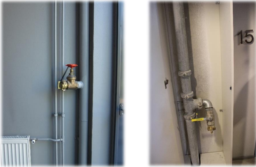
Kuva 65. Kuvissa on nousujohtojen ulosottoja kerroksessa (Latvala).
