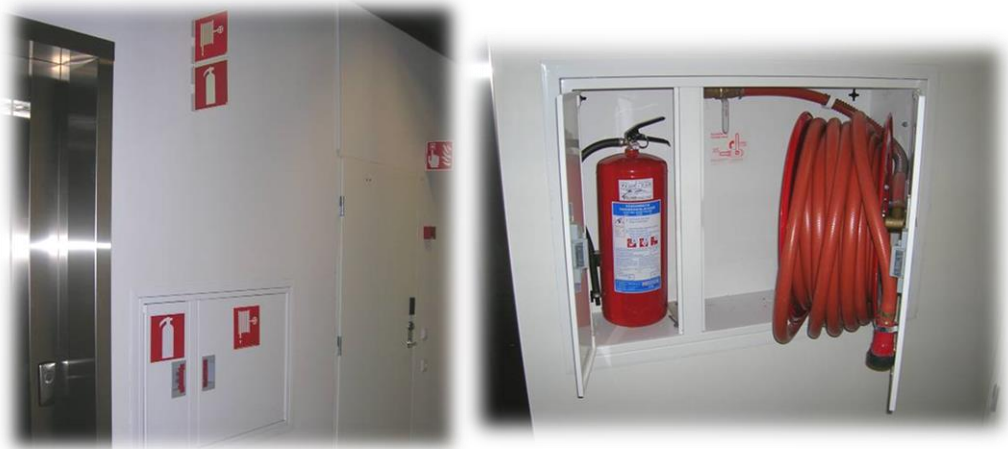
Kuva 67. Alkusammutuskaluston paikat on opastettu rakennuksissa. Kuvassa on vaahtosammutin ja pikapaloposti (Pelastusopisto).
