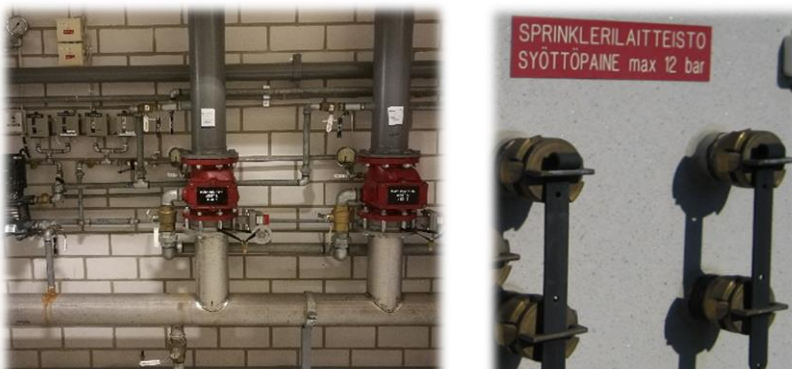
Kuva 55. Vasemmalla kaksi asennusventtiiliä ja oikealla palokunnan syöttöyhteet (Pelastusopisto).
