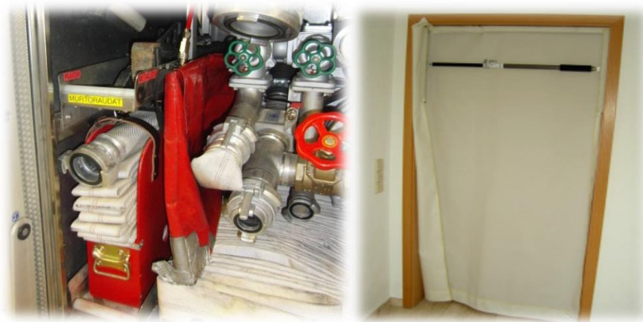
Kuva 19. Vasemmalla savuverho (Smoke Stopper) on valmiina pumpun vieressä (Siitonen), oikealla verho on asennettuna avoimeen oven (Reick).
