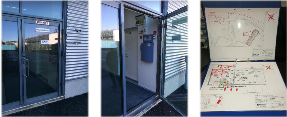
Kuva 51. Vasemmalla opasteet paloilmotinkeskukselle ja avainsäiliö, keskellä pääsy paloilmotintimelle, josta löytyvät paikantamiskaaviot oikealla (Pelastusopisto)
