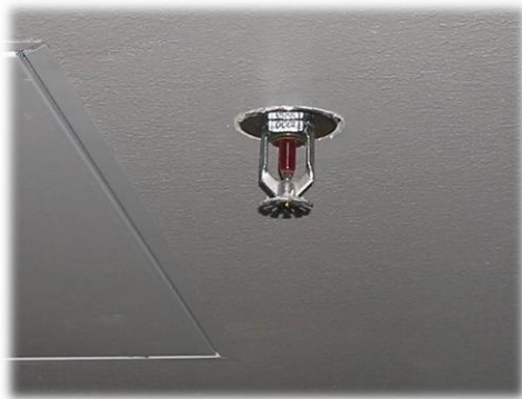
Kuva 56. Vasemmalla kattoon asennettu sprinkleri, oikealla opasteet sprinklerikeskukselle (Pelastusopisto).
