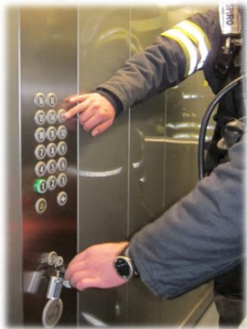
Kuva 63. Palomieshissi otetaan avaimella käyttöön (Latvala).
