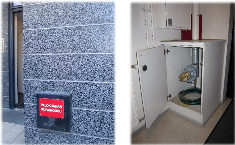
Kuva 64. Vasemmalla nousujohton syöttö on rakennuksen ulkoseinässä, oikeassa kuvassa syöttö on rakennuksen sisällä (Latvala).
