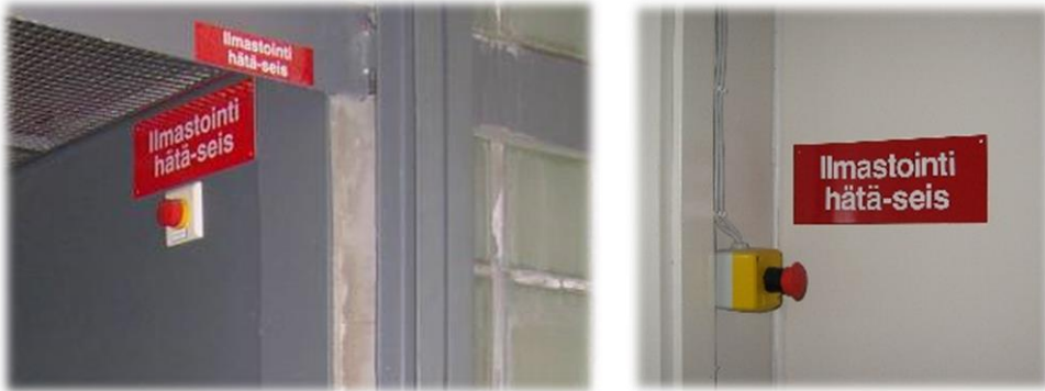
Kuva 54. Porrashuoneessa sijaitseva ilmanvaihdon hätäpysäytyspainike (Pelastusopisto).
