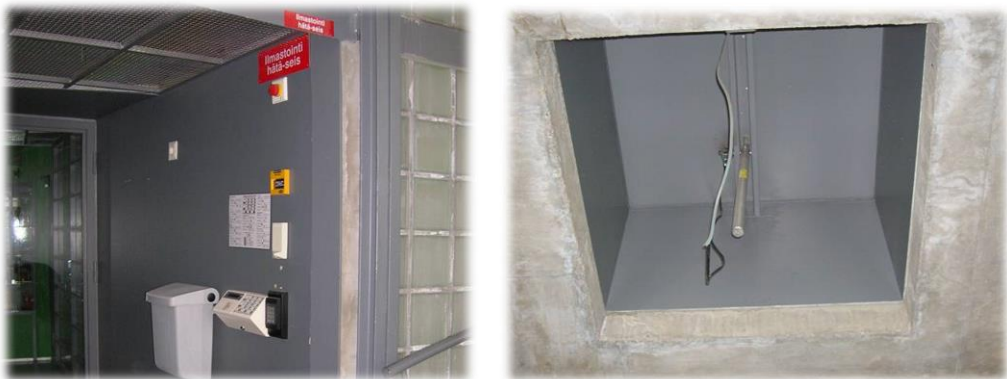
Kuva 52. Vasemmalla kuvassa porrashuoneen keltainen savunpoiston laukaisupainike, oikealla savunpoistoluukku porraskäytävän katossa (Pelastusopisto).
