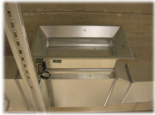
Kuva 53. vasemmalla koneellisen savunpoiston ohjauskeskus. Oikealla kuvassa on koneellisen savunpoiston imukanava ja imupiste ohjattavalla savunhallintapellillä. (Pelastusopisto)
