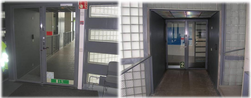
Kuva 60. Palo-osaston rajoja rakennuksen sisällä (Pelastusopisto).
